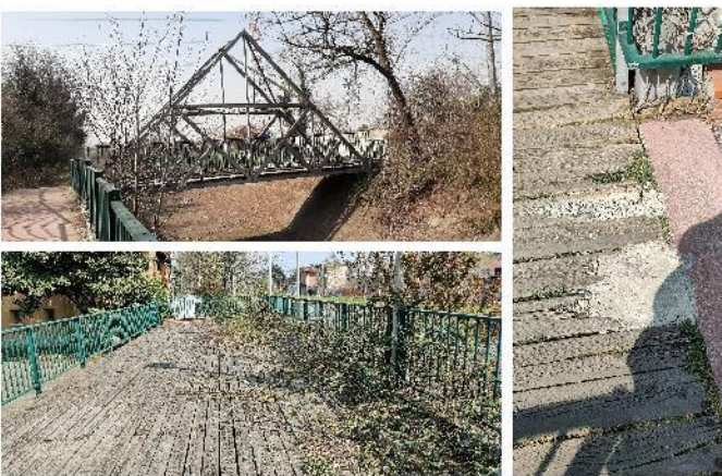
Stato di fatto dei ponti oggetto di riqualificazione.
